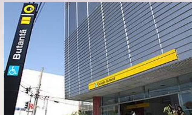
Estação de Metrô - Butantã
