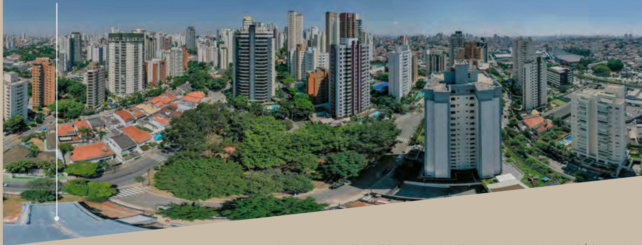
Foto aérea do local
